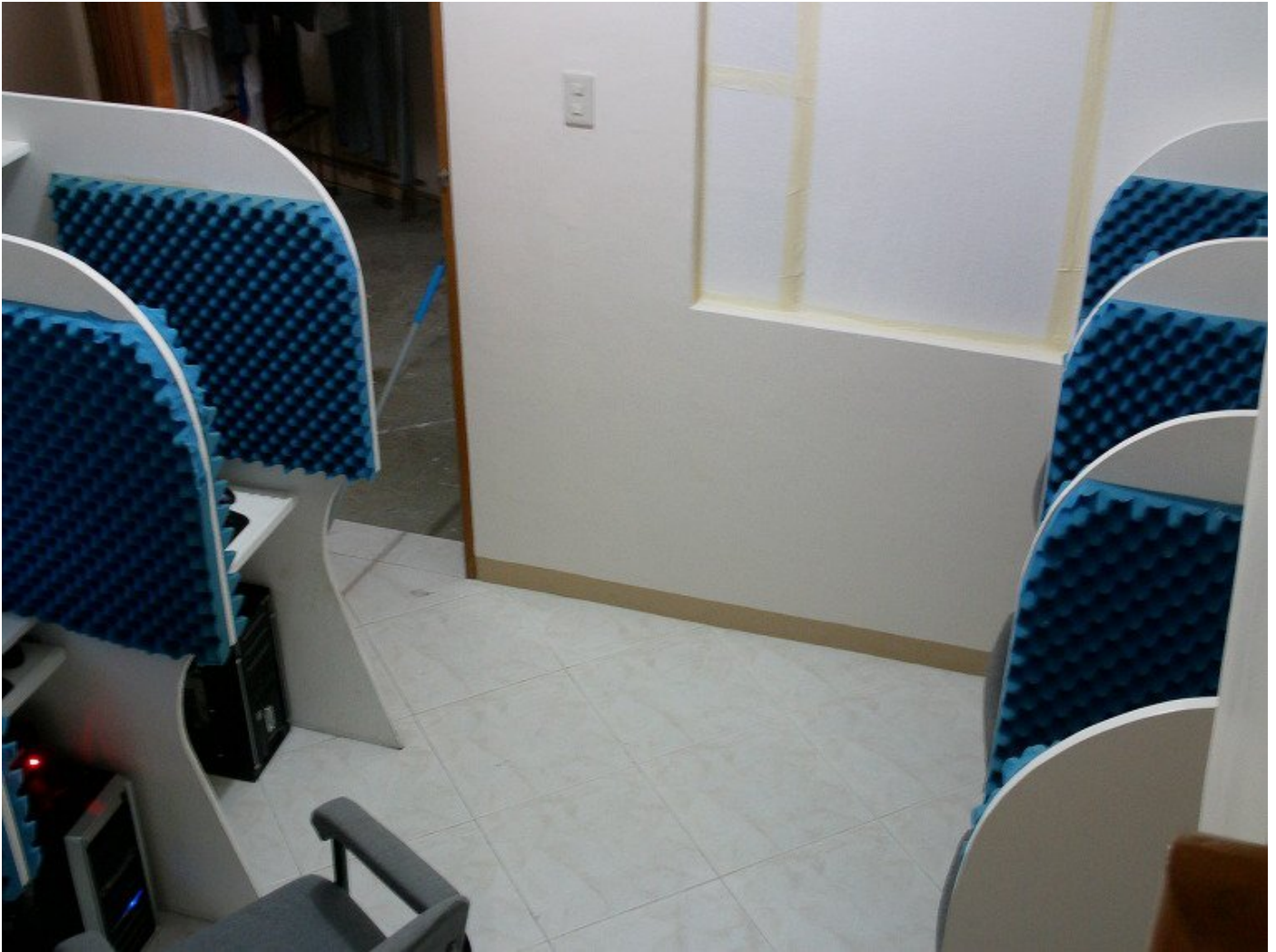
스피로폼이 있는 그림은 원래 창문이 있지만 창문을 통해서 들어오는 소음을 막기 위해 스티로폼으로 방음처리하였습니다.
